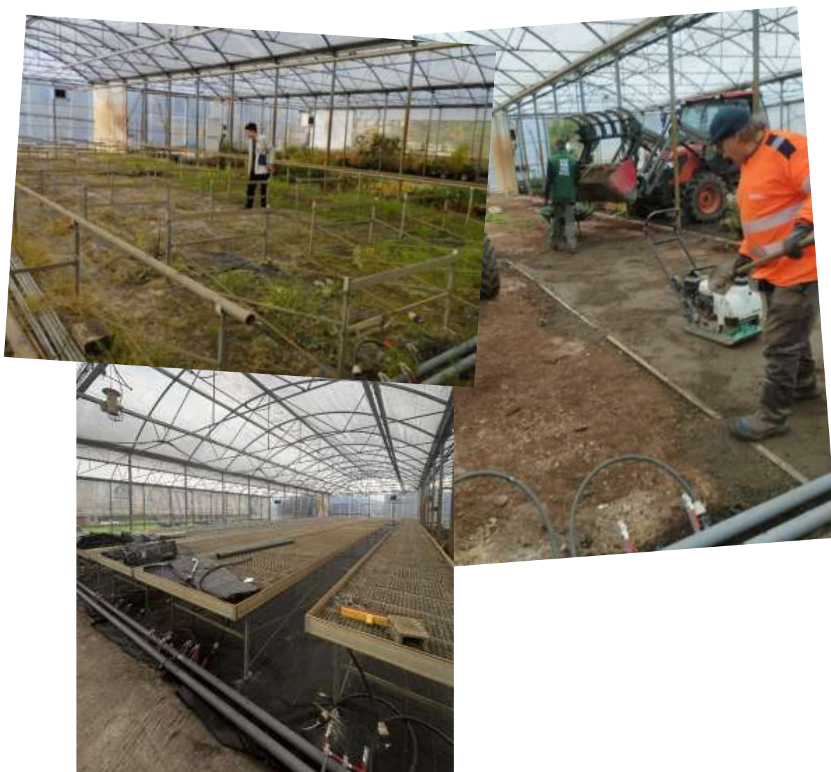
Remise en état de la chapelle tablettes
