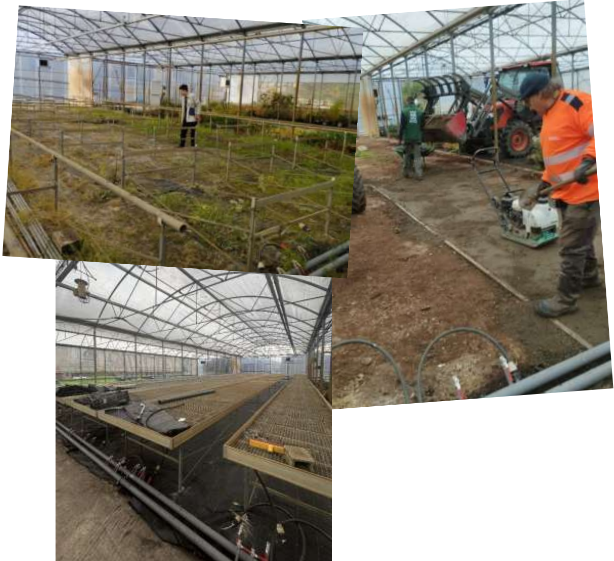
Remise en état de la chapelle tablettes
